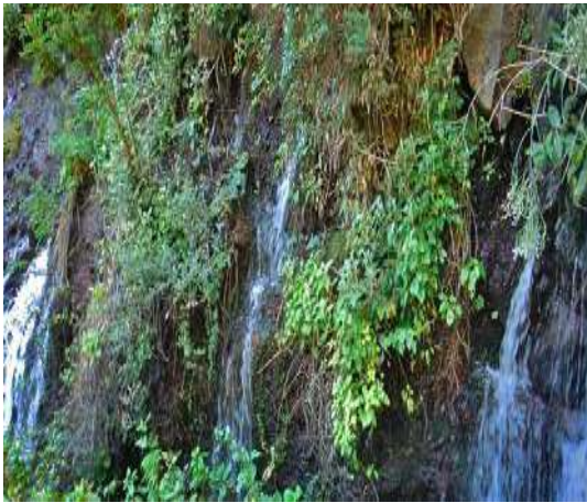
Escorrentias con movimientos de tierra.
